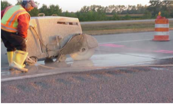
a) Sawcutting the existing slab.
