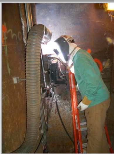
FCAW Welding PJP 6G1
